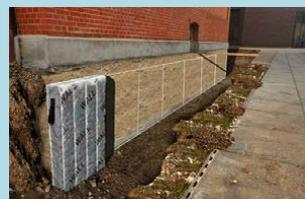
Viowall ist ein neuartiges Gebäudevollschutzsystem auf Basis von Glasschaumgranulat. Die einzelnen Elemente können beim Einbau flexibel verwendet werden und passen sich an jede Architektur an. Anders als bei ähnlichen Lösungen üblich, fällt kein Müll durch Verschnitt oder Verbrauchsmaterialien an und es wird zu 100 Prozent auf Kunststoffe verzichtet.
