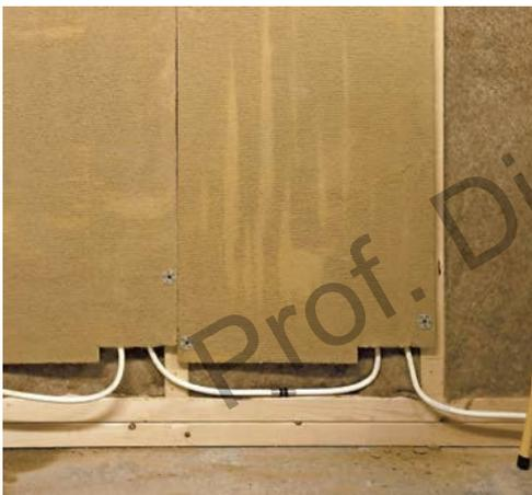
Auf Holzunterkonstruktion montiert ist auch eine Wandheizung möglich.
